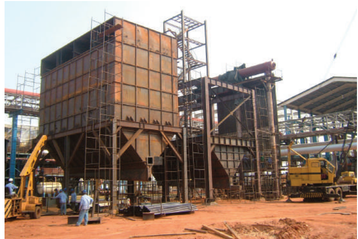
■ Montagem pré aquecedor de ar
