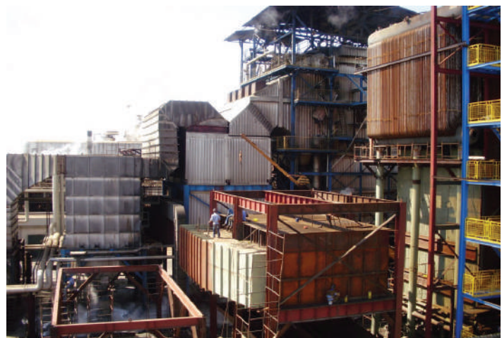
■ Montagem de caldeira
